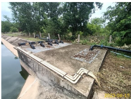
บ่อรวมน้ำเสีย (Wastewater Sump)
